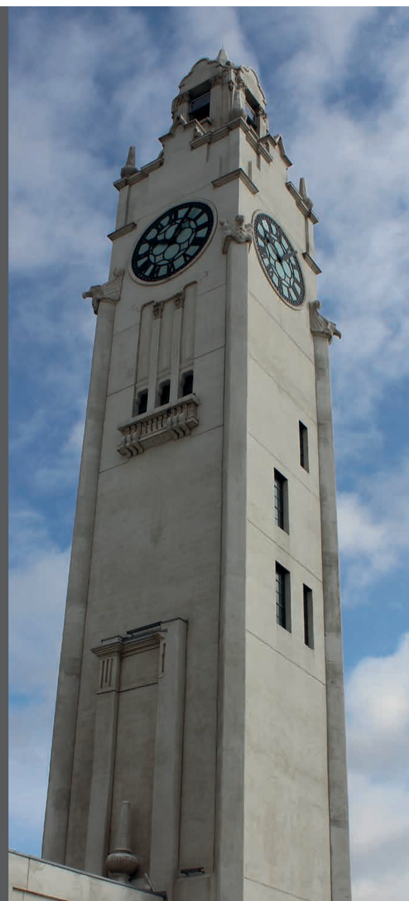
Titre : Tour de l'Horloge, 2012 Provenance : Société du Vieux-Port de Montréal Title: The Clock Tower, 2012 Source: Old Port of Montréal Corporation
